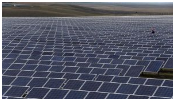
Paneles fotovoltaicos. EFE
