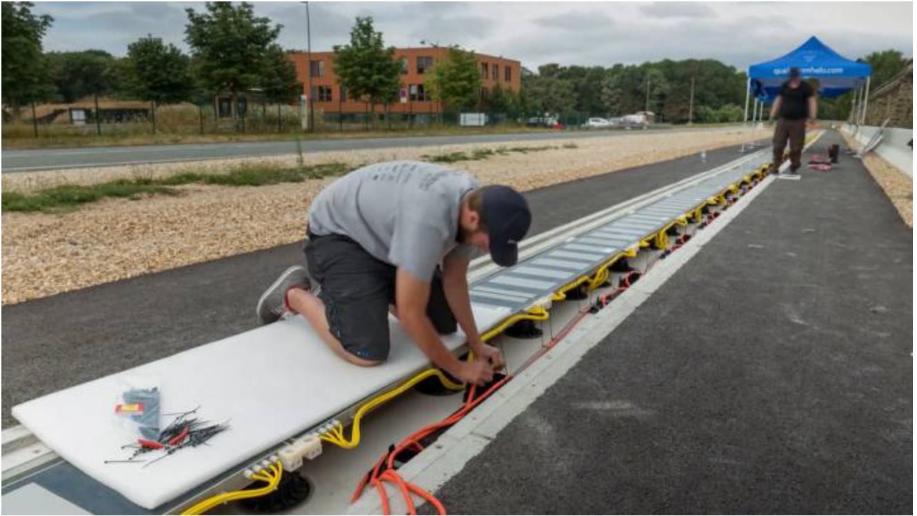
Instalación del sistema de carga dinámica por inducción para coches eléctricos. QUALCOMM
